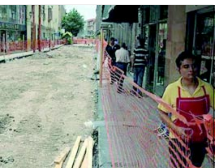
De no concluirse en su totalidad las obras, disminuiría el número de turistas y afectaría a la Procesión del Silencio, advierte José Luis Chalita Manzur.
