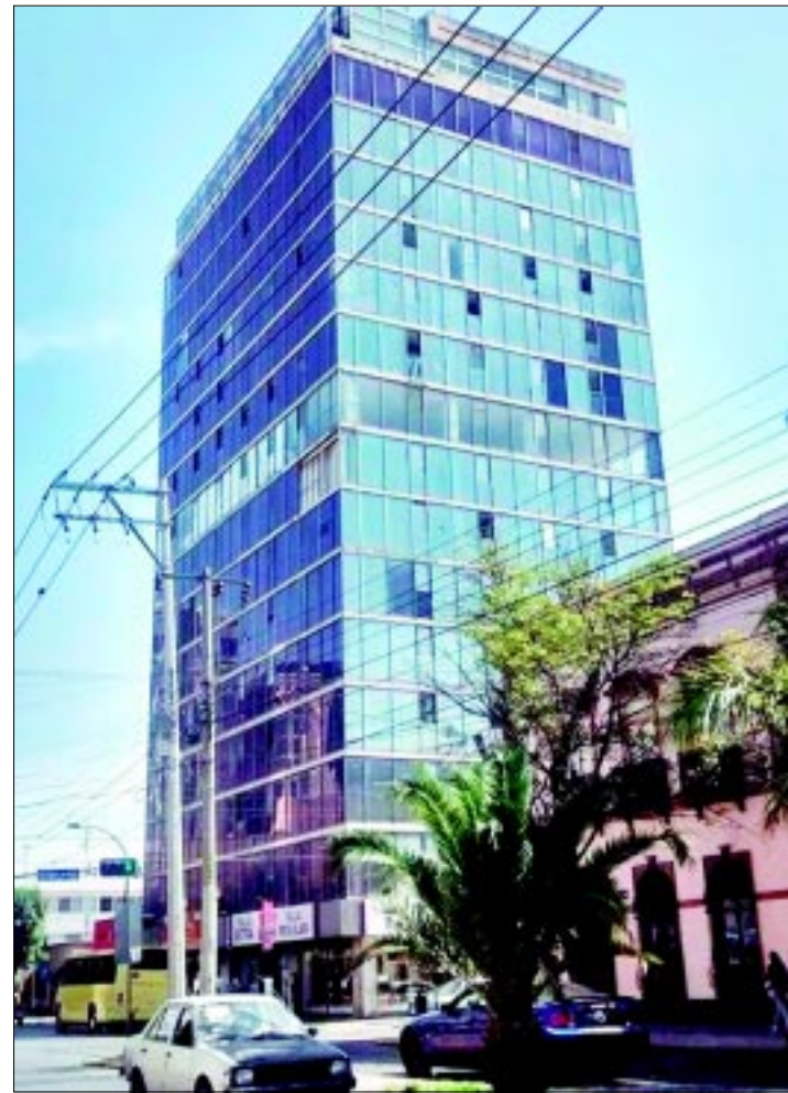
Las ráfagas de viento que se registraron ayer, «mecieron» el edificio Puga, causando el rompimiento de vidrios de oficinas; desprendieron el domo de una escuela, derribaron árboles y daños espectaculares.
