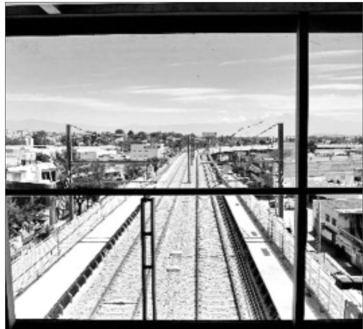
MEXICO.- Un tramo permanece cerrado desde marzo por fallas.
