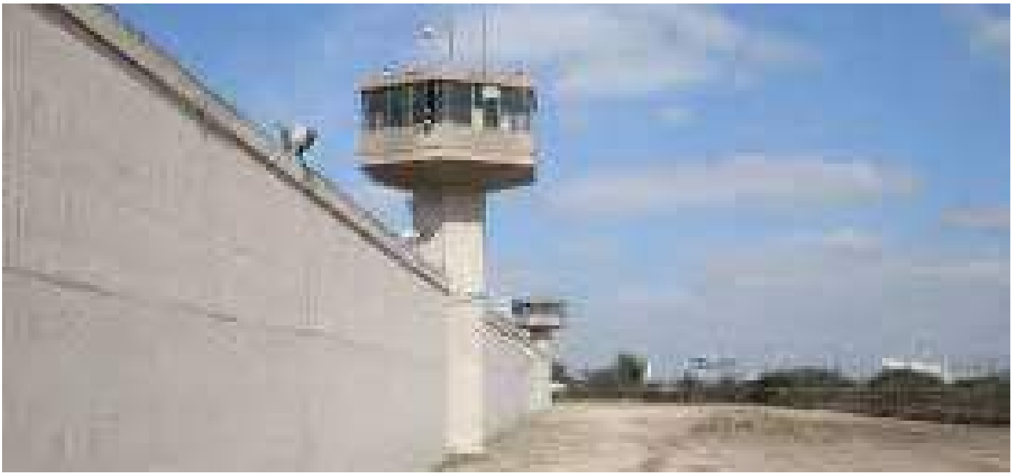
El incidente ocurrió durante los protocolos habituales de control al personal en el acceso del centro penitenciario
